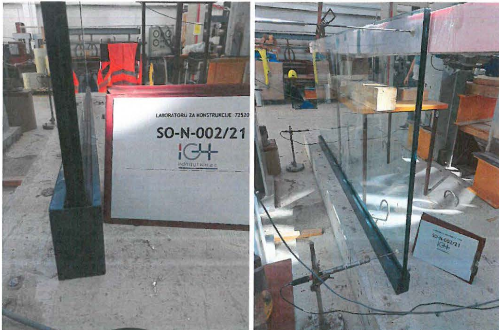
FOTOGRAFIJE 1 i 2 Učvršćivanje čeličnih nosača staklene ograde i postavljanje opreme
